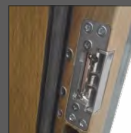
ELEKTROZACZEP ZAMONTOWANY W OŚCIEZNICY TERMO ODS65 i TERMO ODS68
